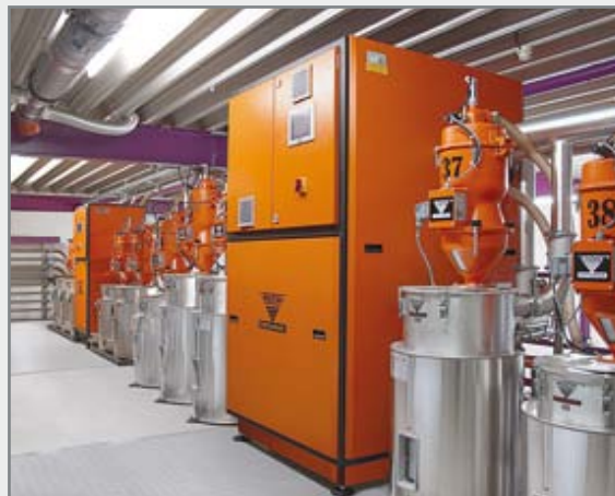
2 CKT 300 avec 12 réservoirs de stockage
